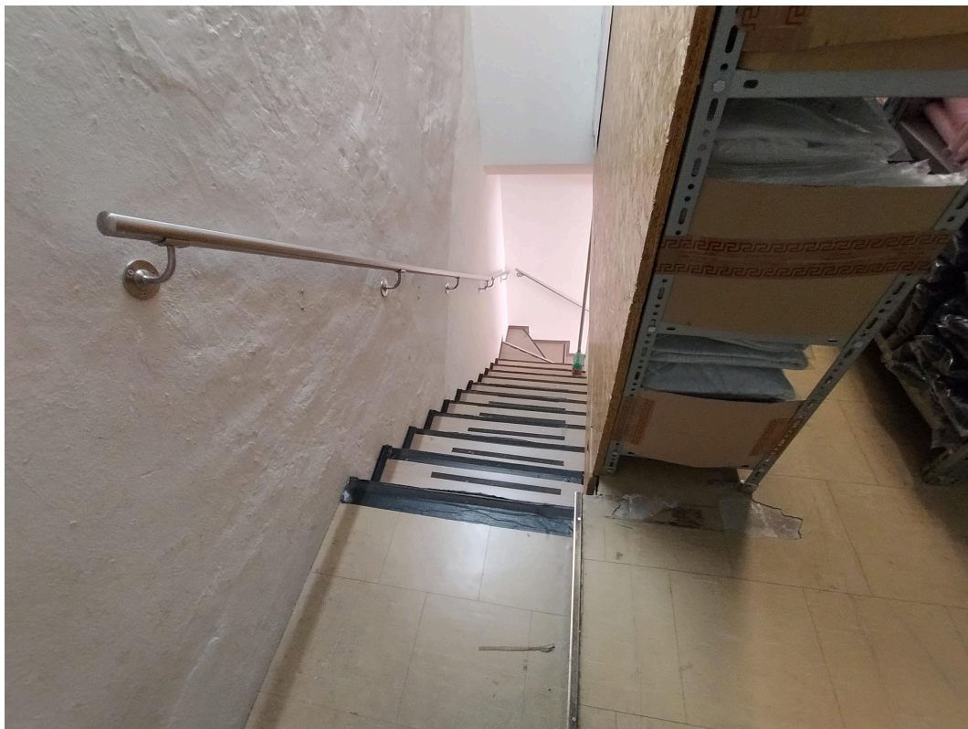
Scala di accesso al piano ammezzato
