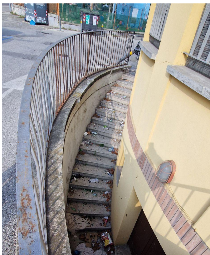
Scala esterna di accesso al piano interrato
