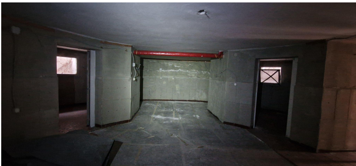
Viste interne piano interrato
