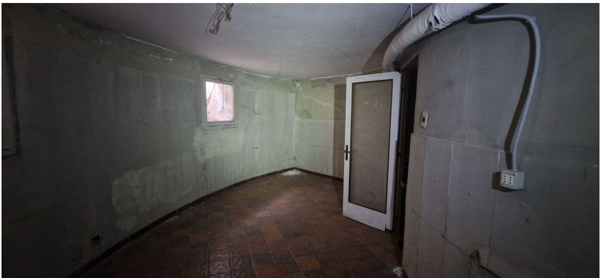
Viste interne piano interrato
