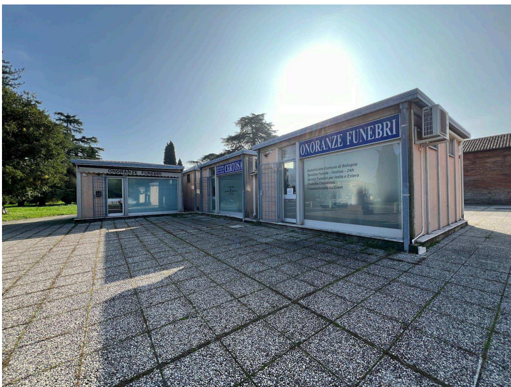
Vista esterna fronte nord
