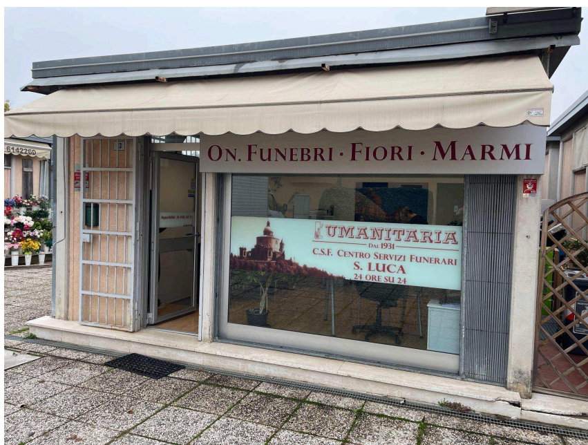
Vista esterna Via della Certosa 73, fronte sud
