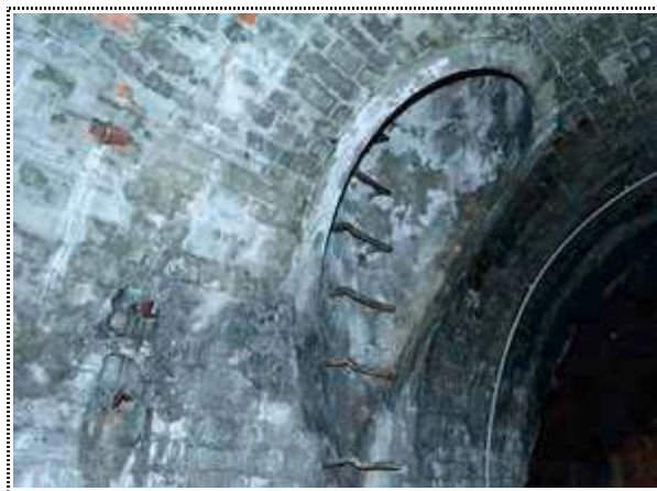
Condotto di aerazione e uscita di emergenza.
