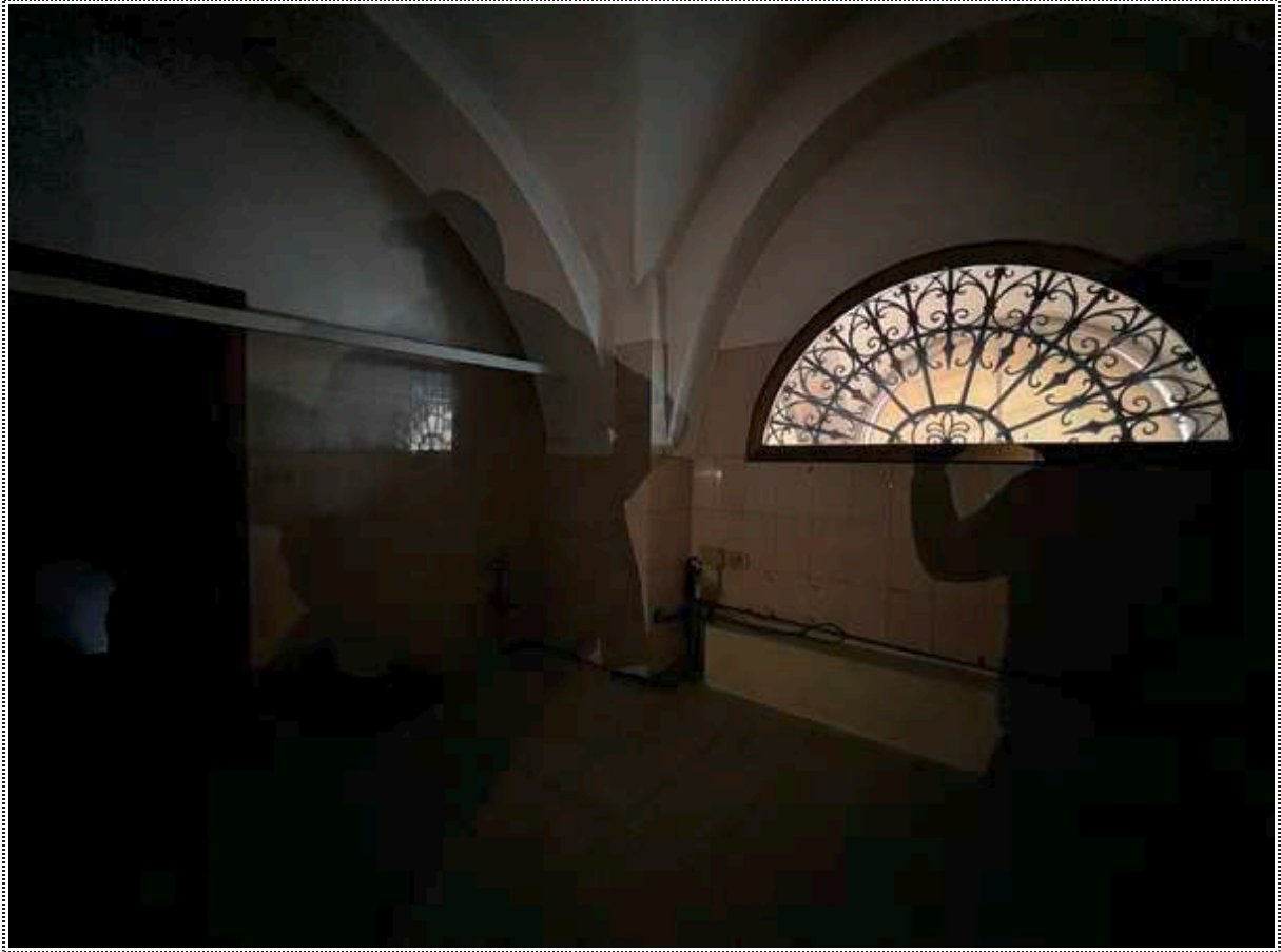
Ex Fill Bar, piano ammezzato
