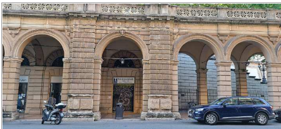
Fronte su Via Dell’Indipendenza
