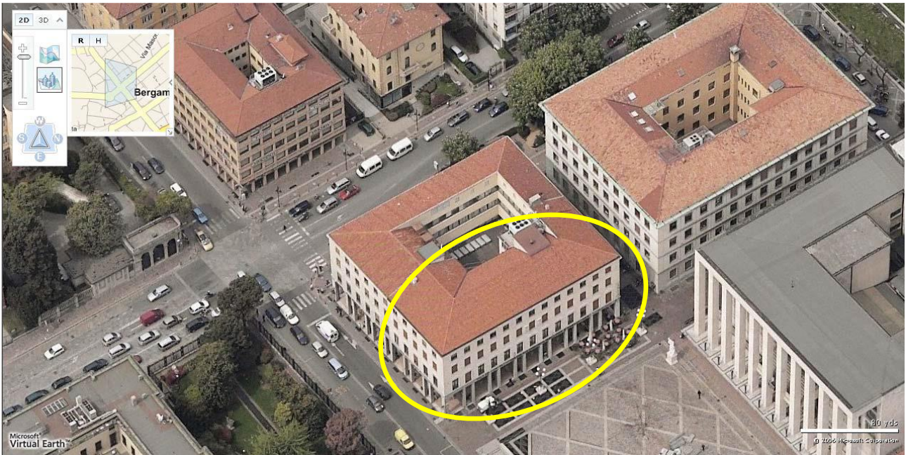
Vista aerea del Palazzo dei Contratti e delle Manifestazioni
